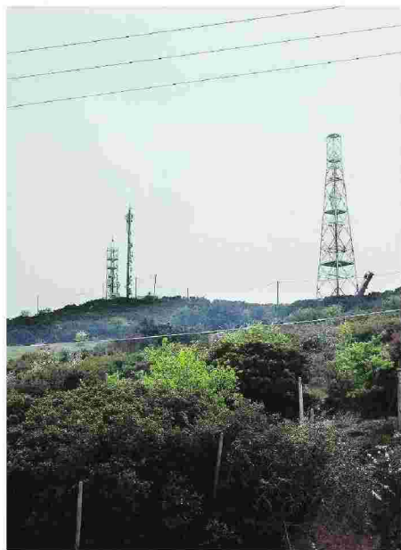
Κεραίες στην περιοχή.
