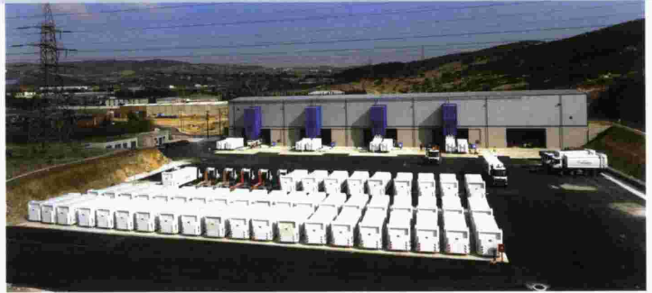
Ο Σταθμός Μεταφόρτωσης Απορριμμάτων (Σ.Μ.Α.) του Βαρειοδυτικού Πολεοδομικού Συγκροτήματος Θεσσαλονίκης.
