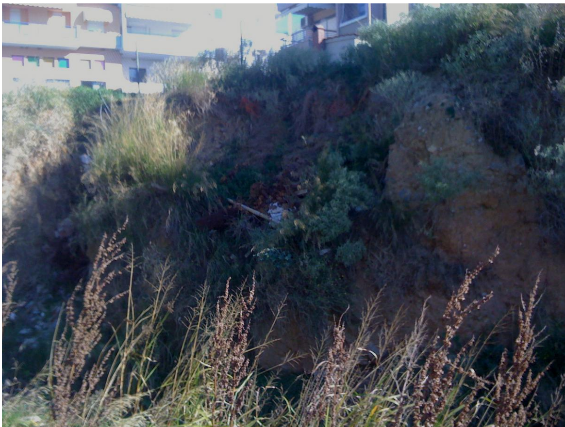
Φωτ. 1,2,3: Άποψη των πρανών και της κοίτης του Ρέματος Σταγειρίτη.
