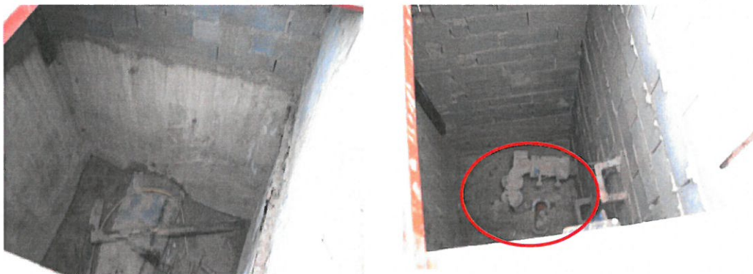
Φωτ. 2, 3: Άποψη των θαλάμων του υφιστάμενου φρεατίου εκκένωσης. Εντός της έλλειψης εμφανίζεται η σύνδεση του αγωγού \varnothing 110 με την παρεμβολή μειωτή πίεσης
