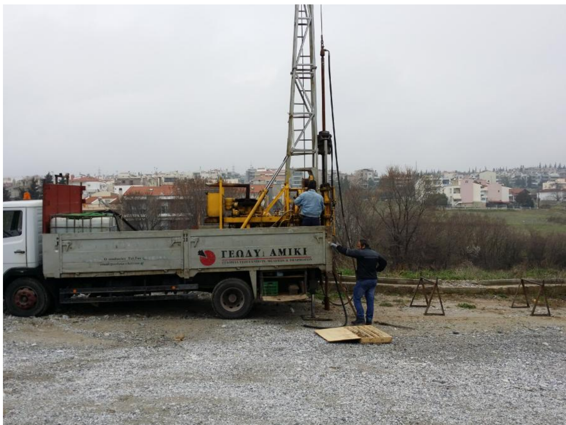
Φωτογραφία 1. Αποτύπωση θέσης γεώτρησης Γ 1 .
