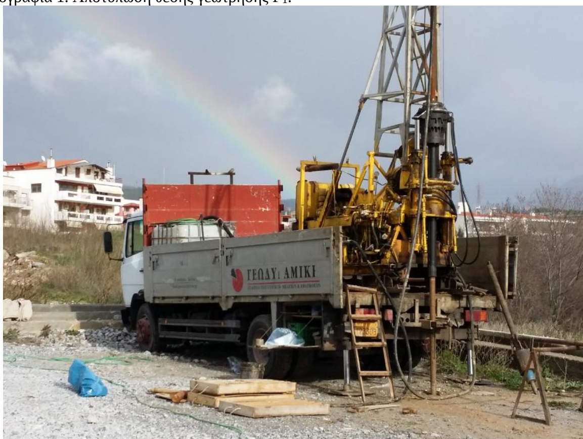
Φωτογραφία 2. Αποτύπωση θέσης γεώτρησης Γ 2 .
