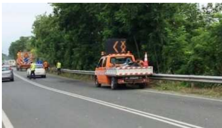
Εργασίες συντήρησης στην Εθνική οδό Θεσσαλονίκης - Καβάλας
