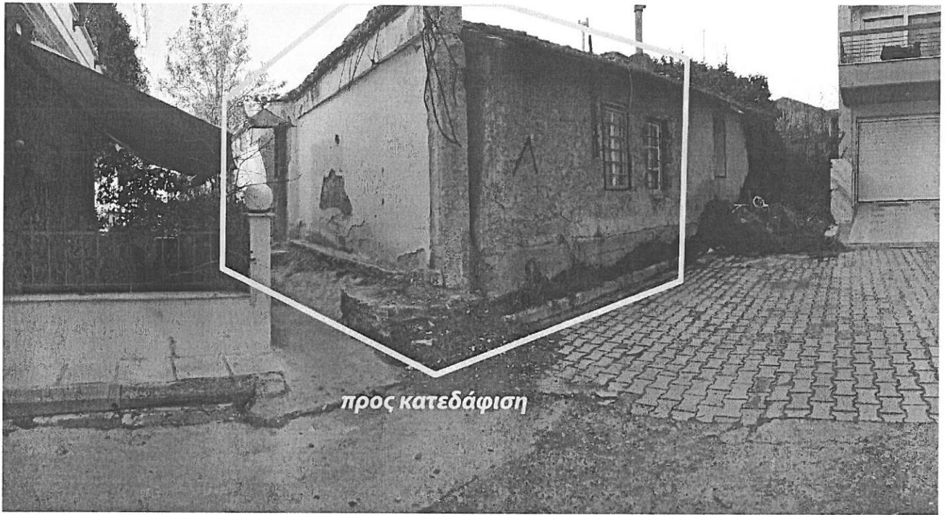
ΦΩΤΟ 5. Όψη Κτίσματος προς κατεδάφιση
