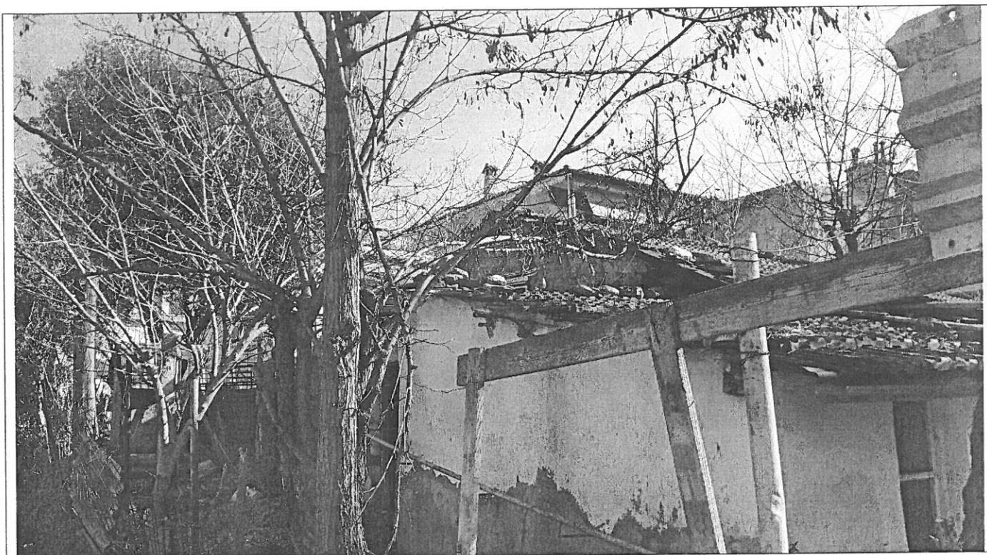
ΦΩΤΟ 8. Όψη Κτίσματος προς κατεδάφιση
