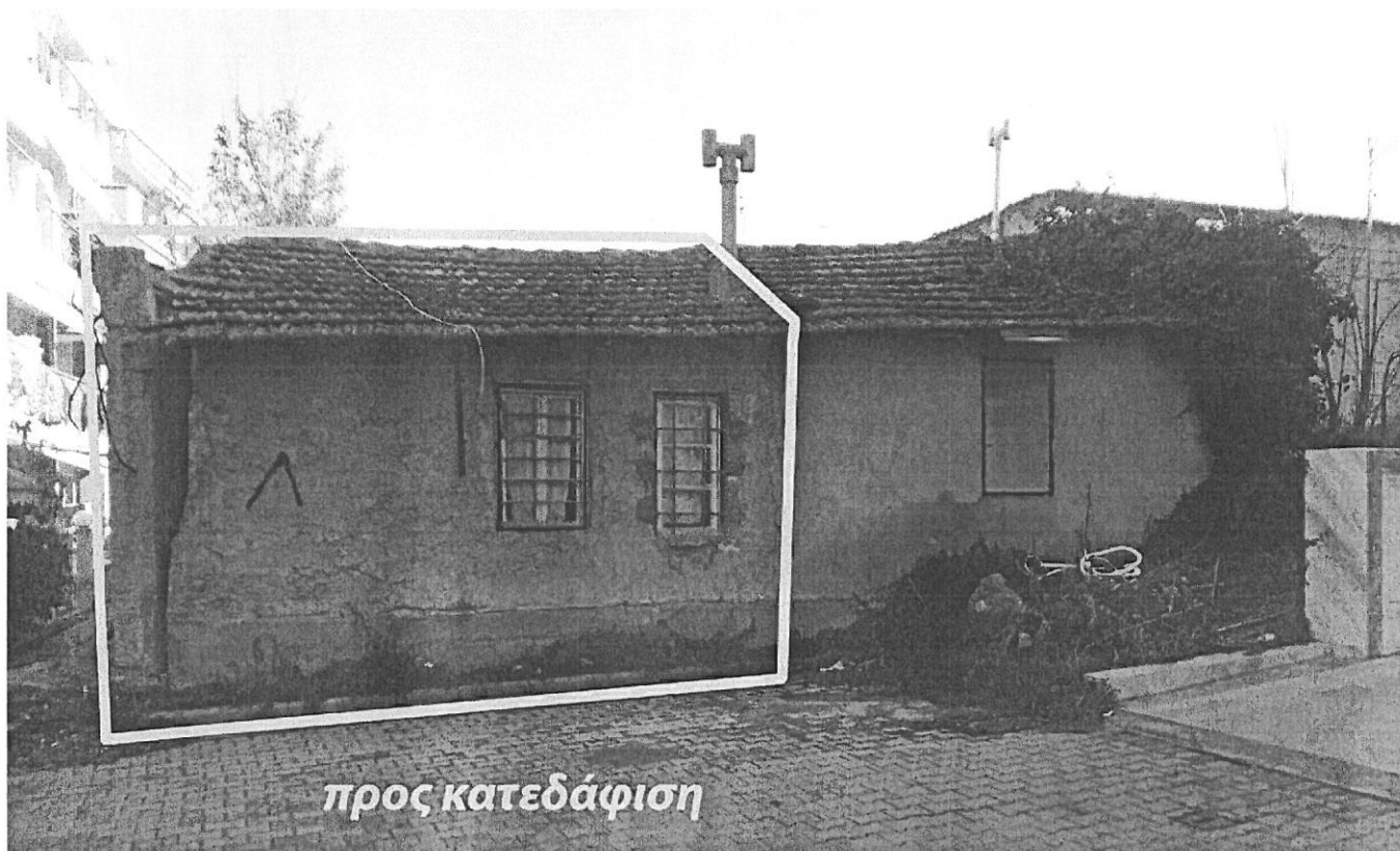
ΦΩΤΟ 4. Όψη Κτίσματος προς κατεδάφιση
