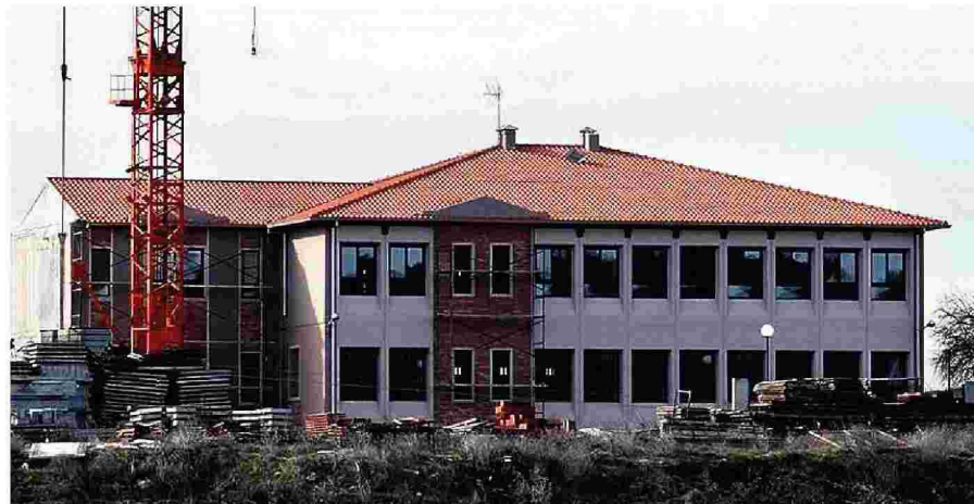
Εικόνα από την ανέγερση του σχολικού κτιρίου.
