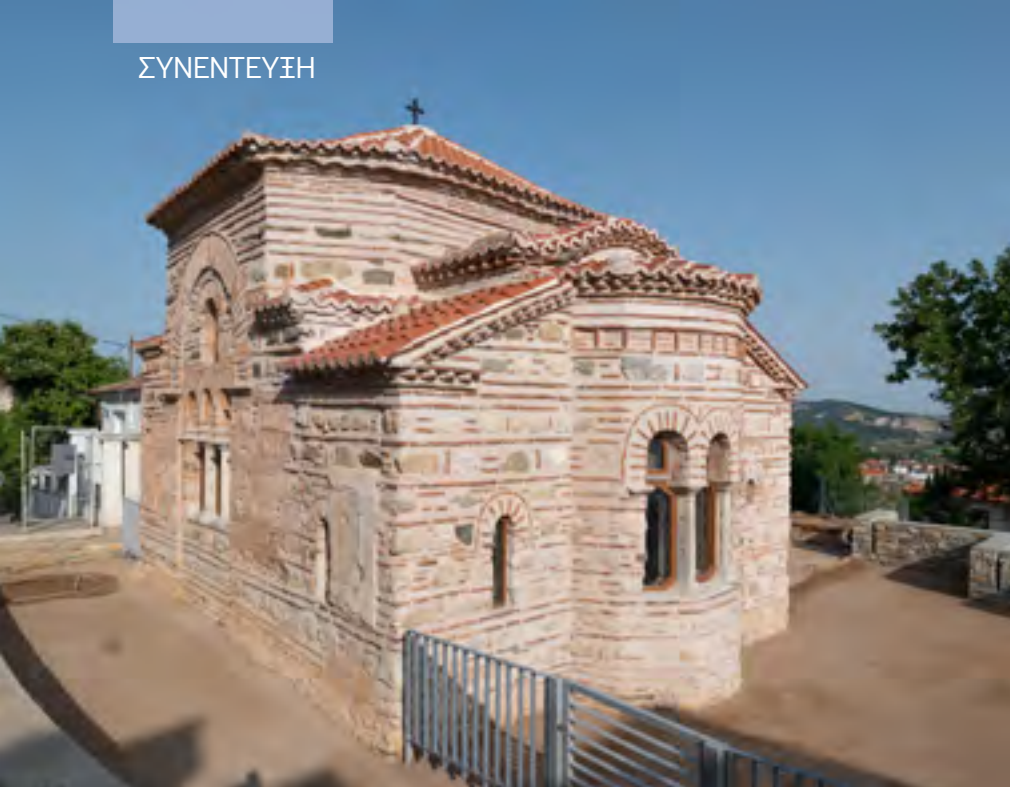
// Ο ναός της Μεταμόρφωσης του Σωτήρα μετά τις εργασίες αποκατάστασης
