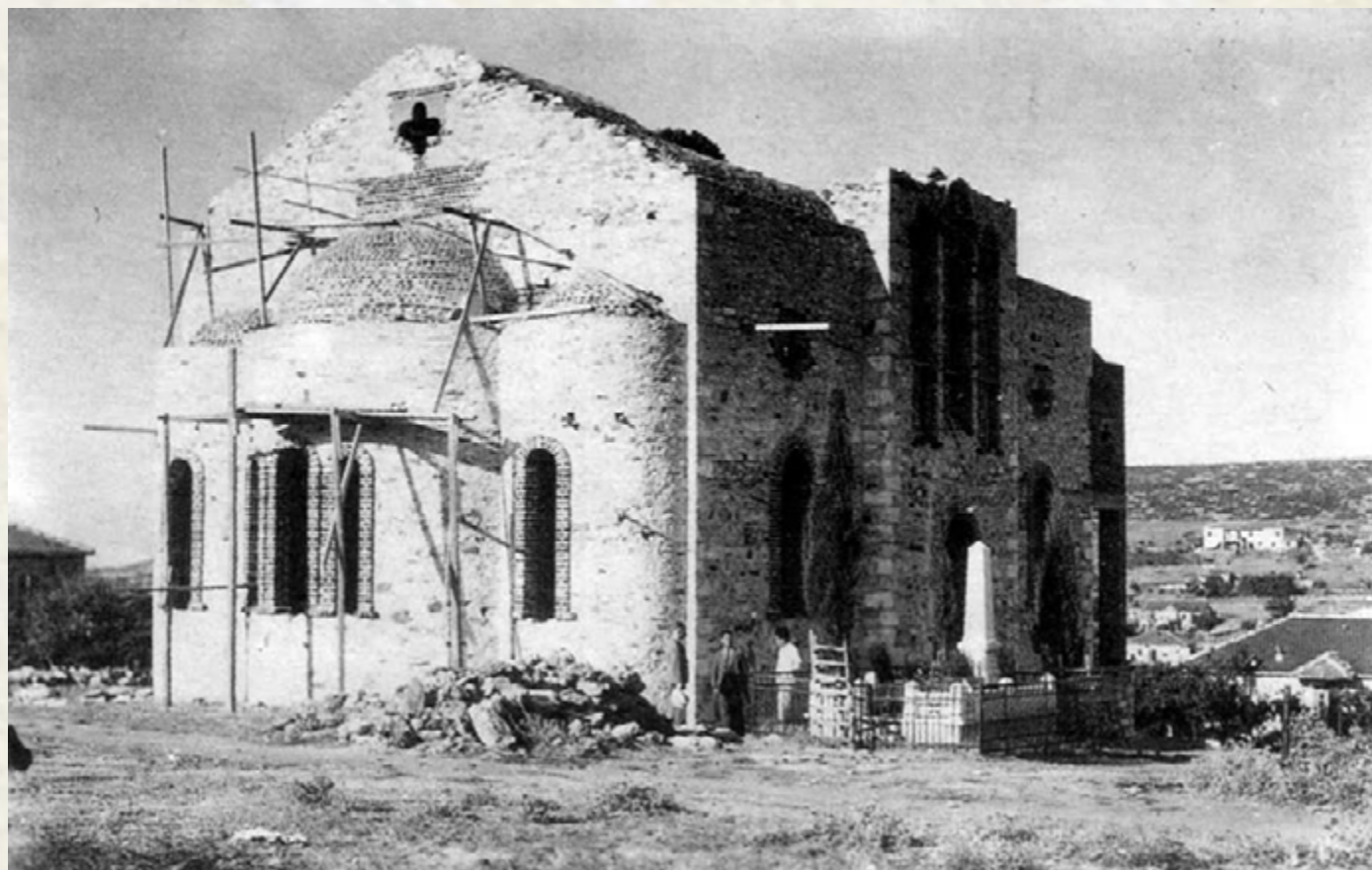
Η εκκλησία του Αγ. Γεωργίου υπό κατασκευή
