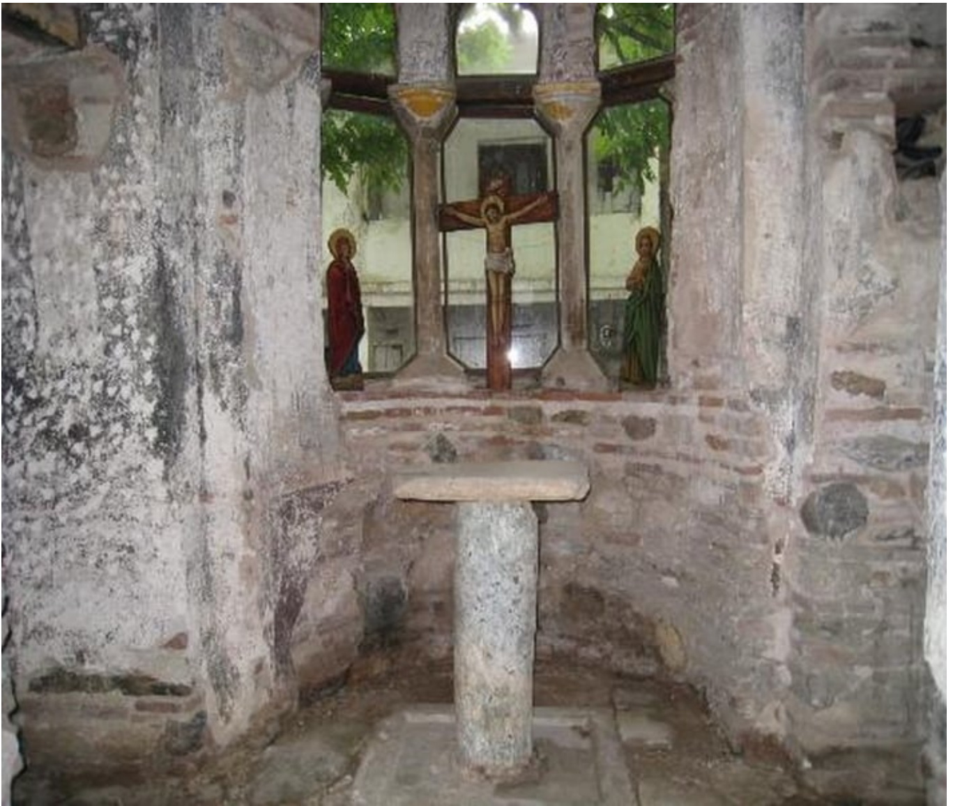
Η κόγχη του ιερού με την Αγία Τράπεζα, πριν από την αναστήλωση (φωτ.: Υπουργείο Πολιτισμού, Παιδείας και Θρησκευμάτων)
