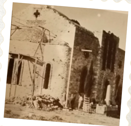
// Η εκκλησία του Αγ. Γεωργίου υπό κατασκευή (φωτ.: Αρχείο Θ. Λαζαρίδη)
