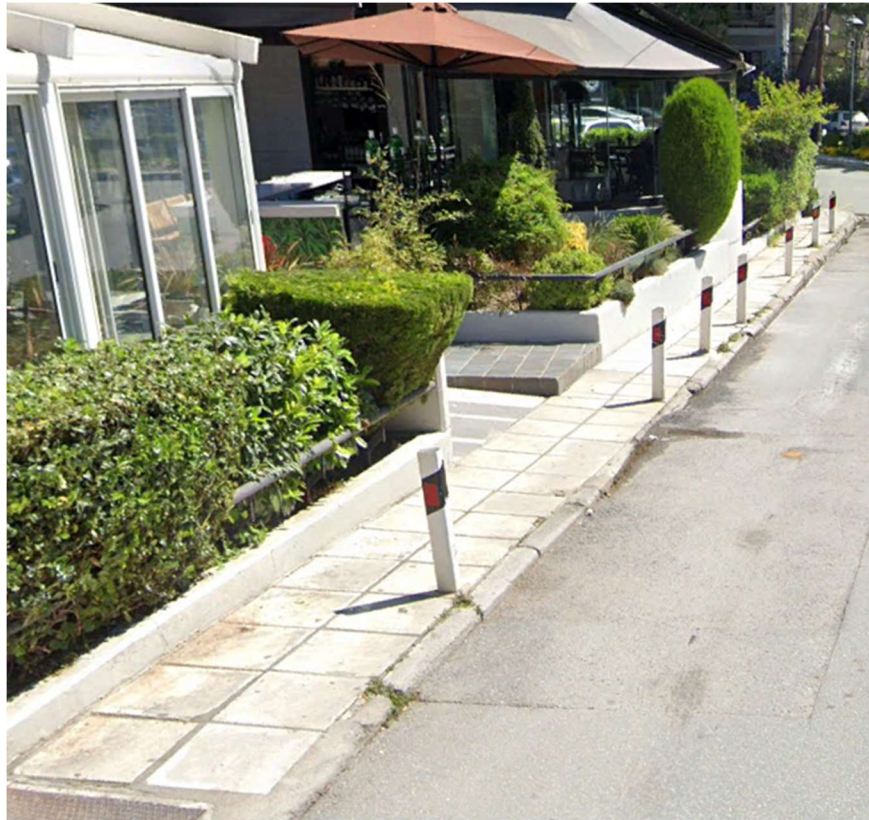
Εικόνα 33: Οδός Παπαδοπούλου 1 Κατάσταση Πεζοδρομίων και Αποτρεπτικά Κολωνάκια Στάθμευσης
